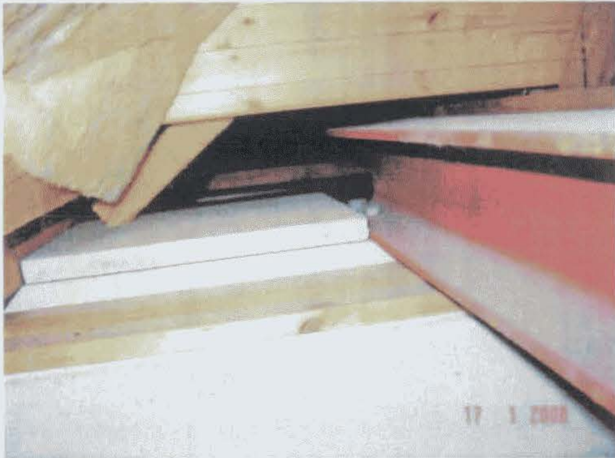
Bild 16: Bau L, Achse 2432 Flur Verkleidungsplatten oberhalb der abgeh. Decke
