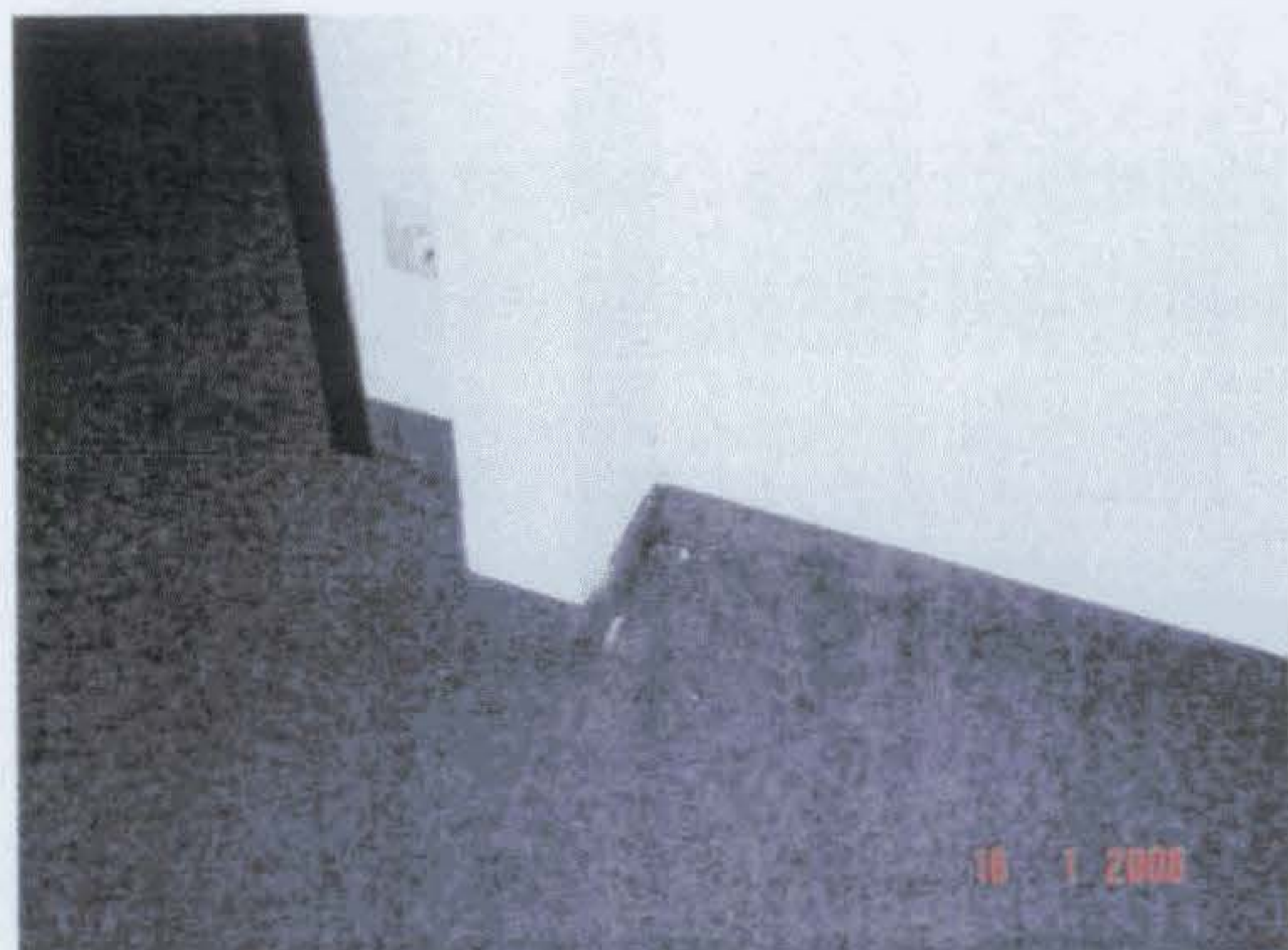
Bild 13: Bau C, Achse 234 Bürraum kleine Stütze mit Gewebe und Brandschutzverkl
