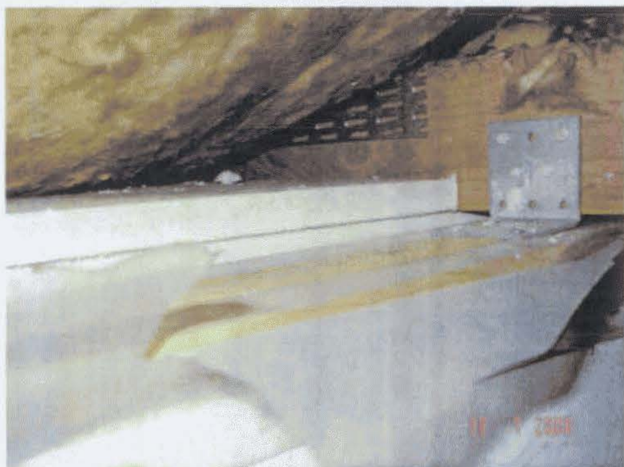
Bild 21: Bau L, Achse 3405 Raum Trägerverkleidung
