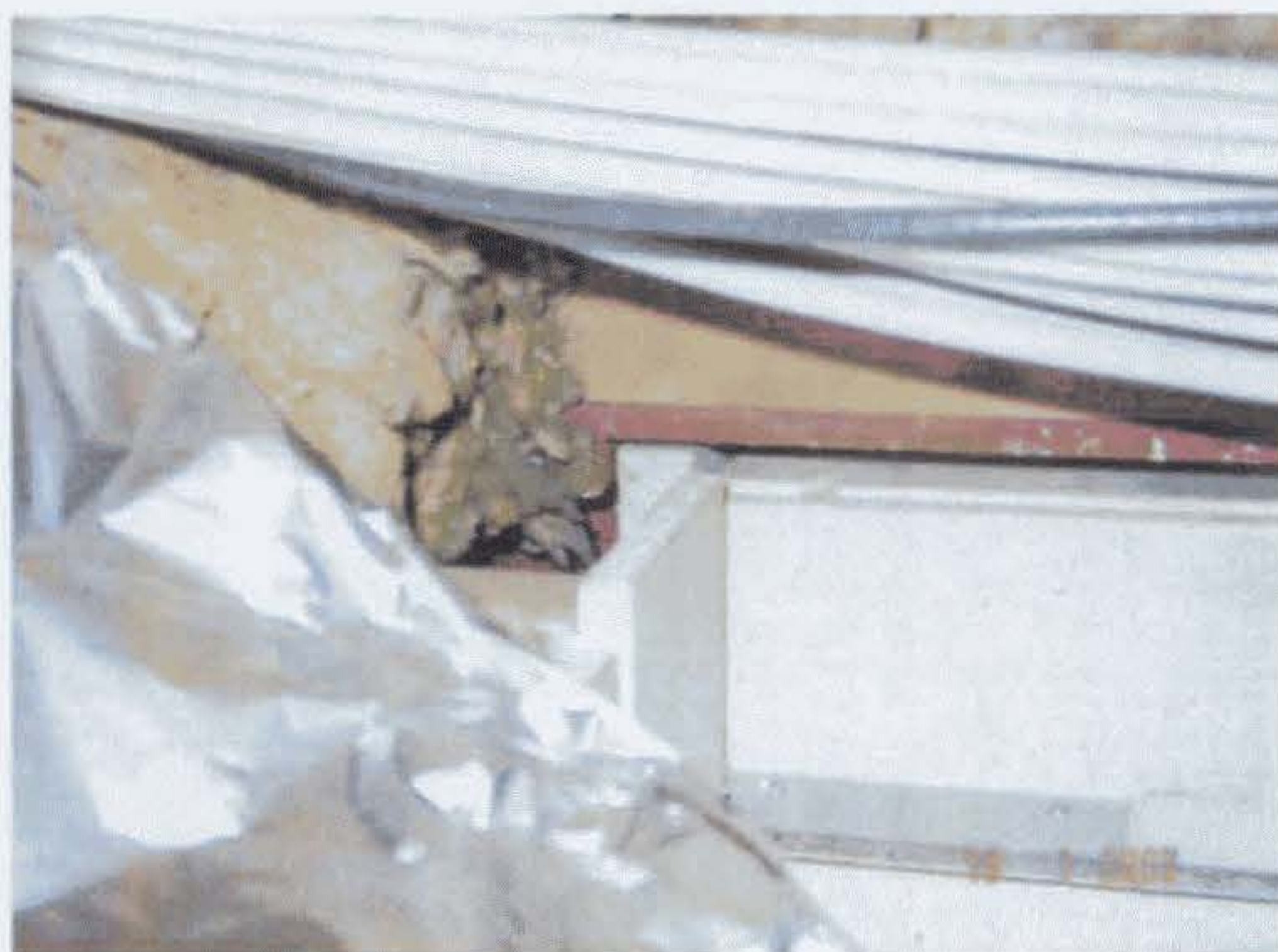
Bild 2: Bau K, Achse 219 Raum, Flurseite Mittelstütze mit allseitige Verkleidung
