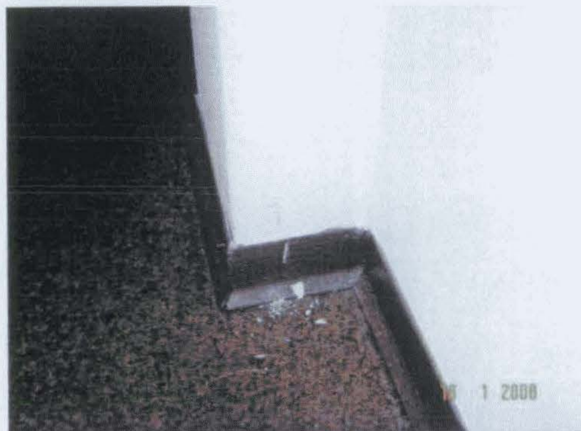
Bild 14: Bau B, Achse 202/203 Flur Brandschutzverkl. vor Stützen
