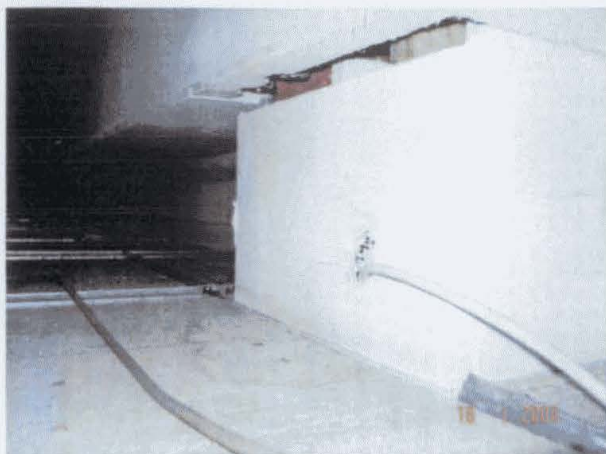
Bild 3: Bau K, Achse 222 Flur Stützen- und Querträgerverkl., hinter abgeh. Decke
