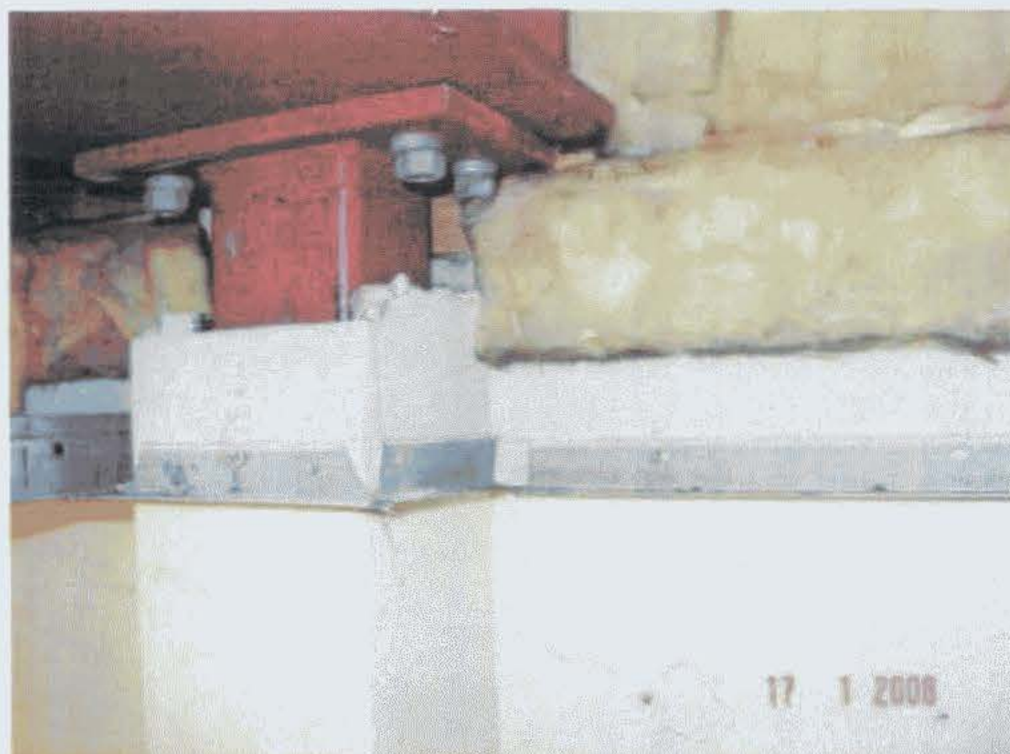
Bild 18: Bau L, Achse 2307 Raum Verkl. Platten kleine Stütze Außenwand
