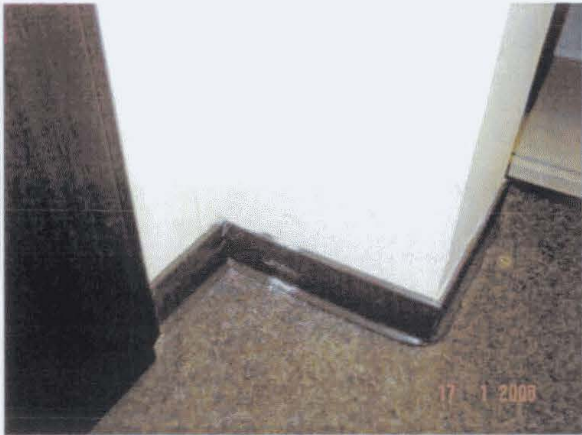
Bild 19: Bau L, Achse 2360 Raum Stütze zum Flur, Verkl. Platte
