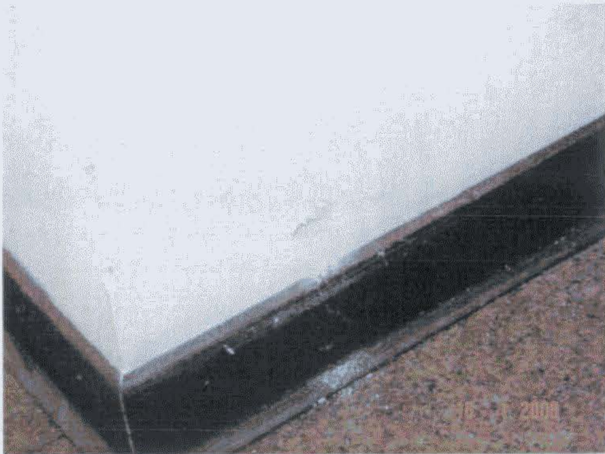
Bild 4: Bau K, Achse 206 Raum, Fensterseite Stützenverkleidung
